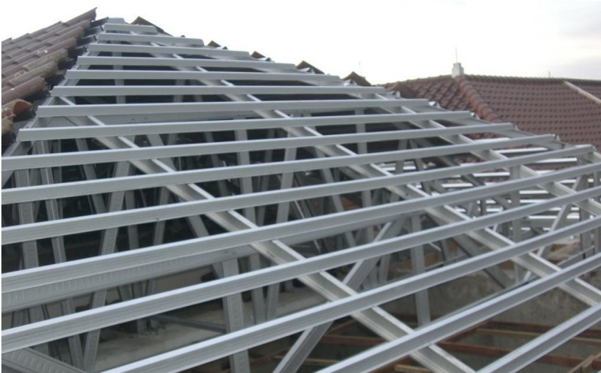
Gambar 127. Aplikasi balok gerber pada rangka atap
